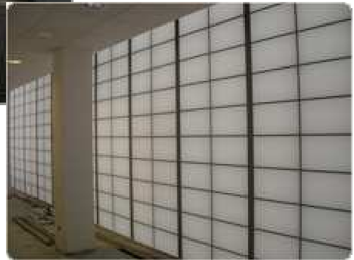
Edificio con paneles de Policarbonato Compacto, Diciembre 2008
